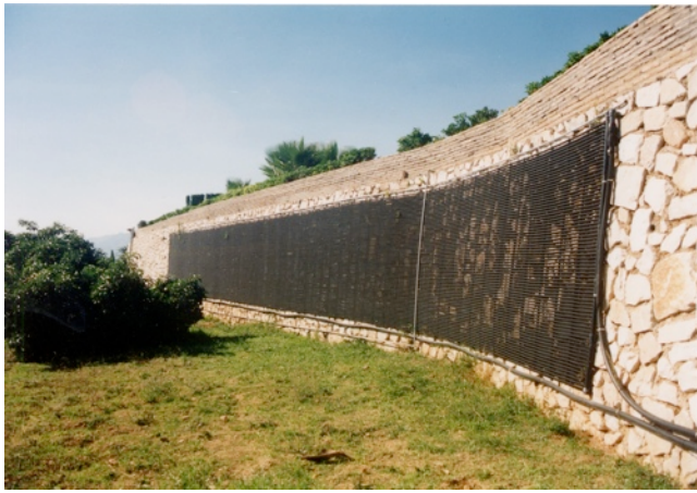
Solarabsorber senkrecht an einer Mauer montiert.
