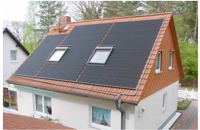
Solarabsorber mit exakten Fensterausparungen.
