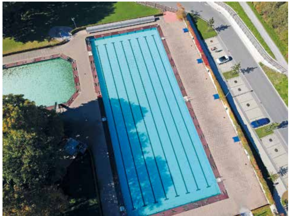
Das Freibad in Kolbermoor (Bayern) hat eine neue Solarheizung für das Badewasser bekommen.
