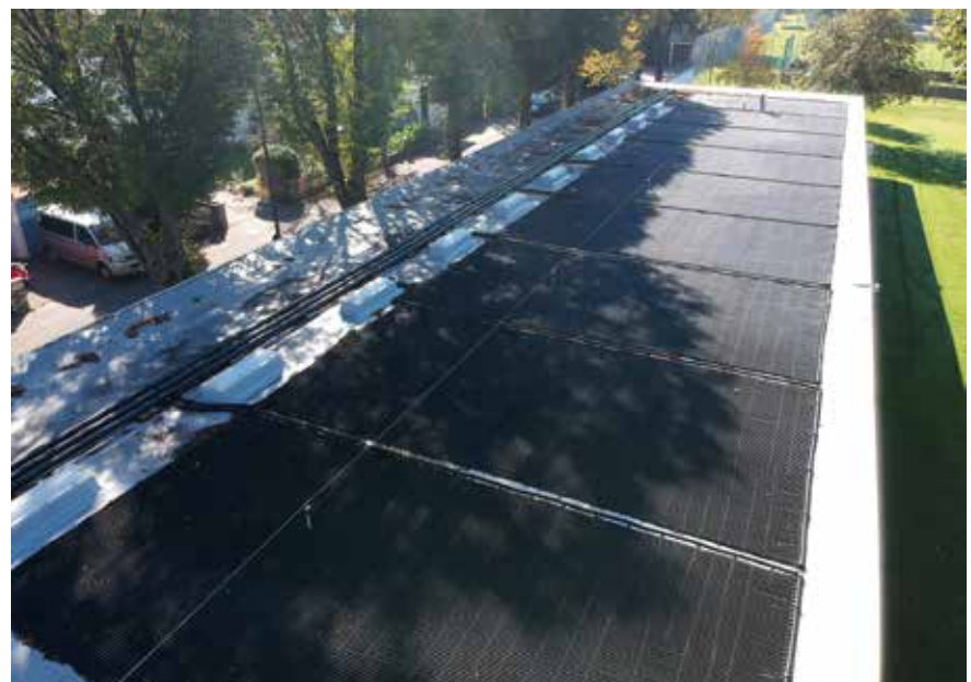
Auf dem Flachdach der Umkleidekabinen wurden die „solar-rapid“-Register verlegt. Sie erwärmen das Poolwasser auf angenehme Badetemperatur.
