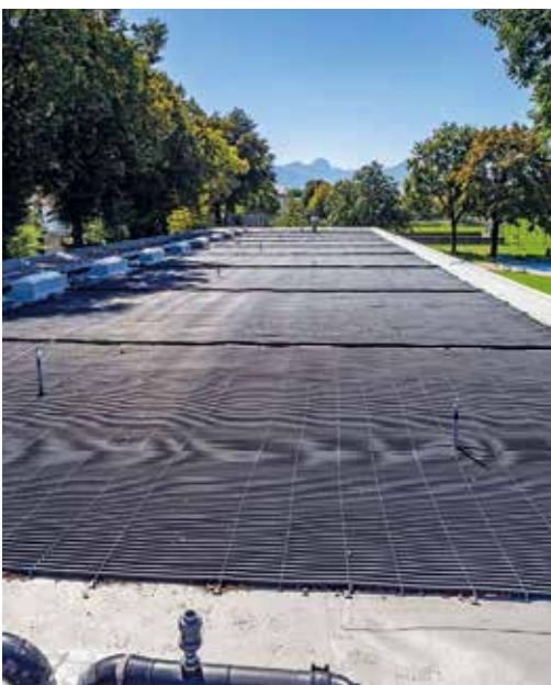
Auf dem Flachdach der Umkleidekabinen wurden die „solar-rapid“-Register verlegt. Sie erwärmen das Poolwasser auf angenehme Badetemperatur.
